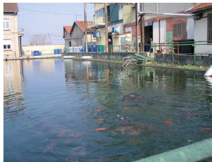
Bassin de refroidissement du bâtiment de synthèse du site PCAS de Bourgoin-Jallieu
